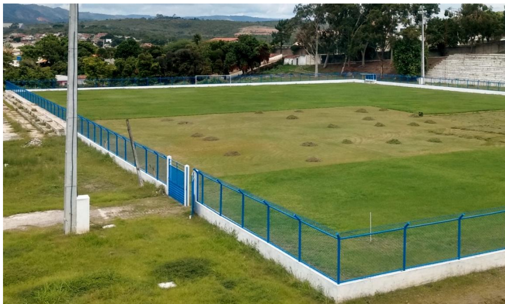
Foto 01 – Execução do alambrado com mureta
