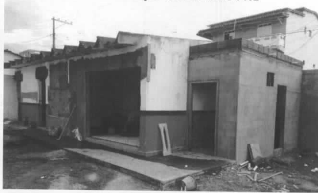
Foto 08 – Execução do banheiro PNE
