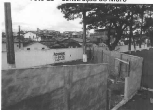
Foto 12 – Construção do Muro
