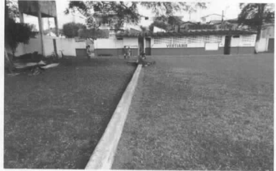
Foto 02 – Remoção do Alambrado P/Execução do Muro
