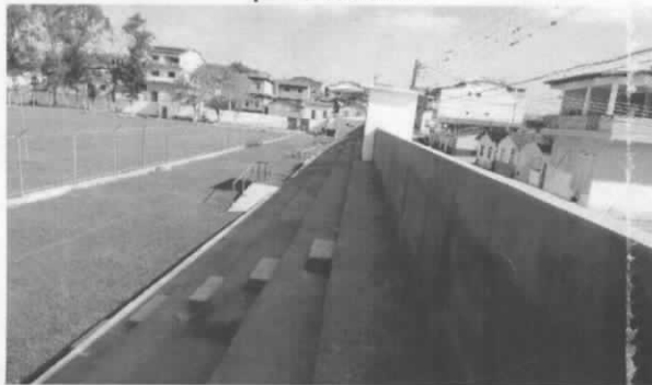
Foto 05 – Substituição de gradil atrás da arquibancada por alvenaria
