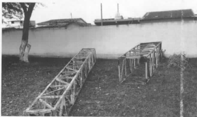
Foto 07 – Remoção das antigas torres de iluminação;
