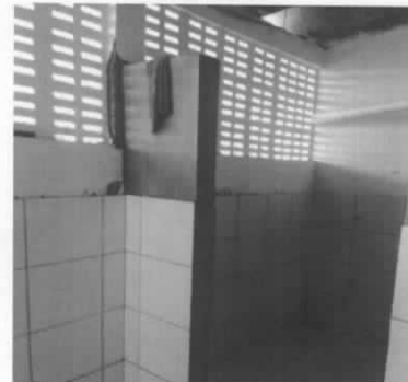
Foto 04 – Assentamento de revestimento cerâmico no vestiário
