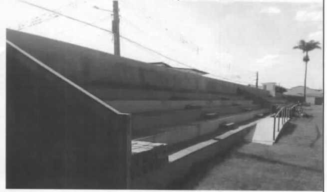
Foto 06 – Execução da rampa de acessibilidade
