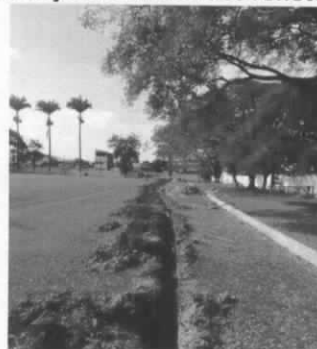
Foto 10 – Escavação de valas para passagem das instalações elétricas dos refletores
