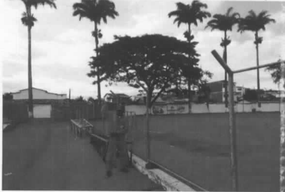
Foto 01 – Remoção do Alambrado P/Substituição
