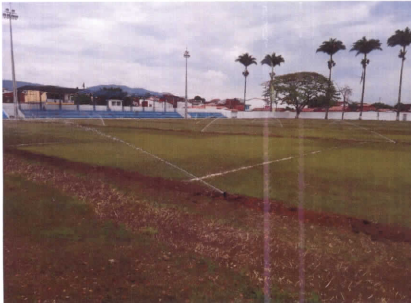
Foto 02 - Vista parcial destacando o gramado e o sistema de irrigação em operação
