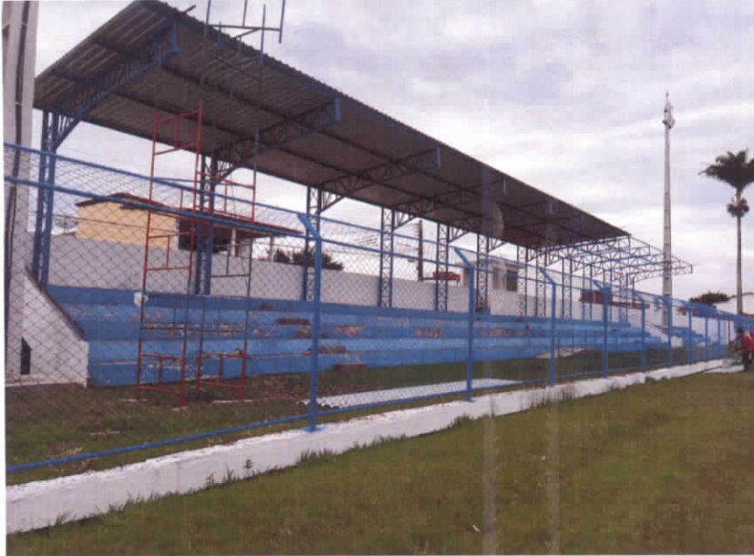
Foto 01 – Vista parcial destacando a arquibancada coberta, alambrado, gramado e iluminação do gramado
