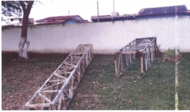
Foto 07 – Remoção das antigas torres de iluminação;
