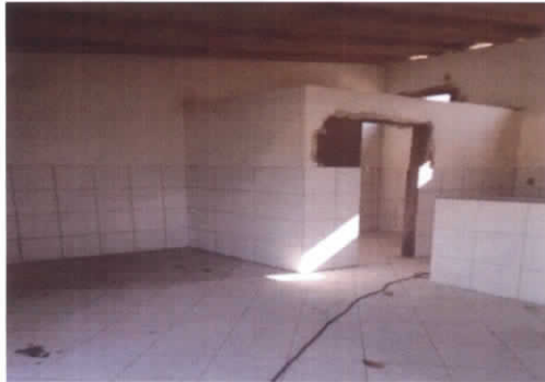
Foto 03 – Assentamento de Revestimento Cerâmico no Bar
