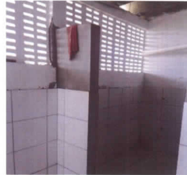
Foto 04 – Assentamento de revestimento cerâmico no vestiário
