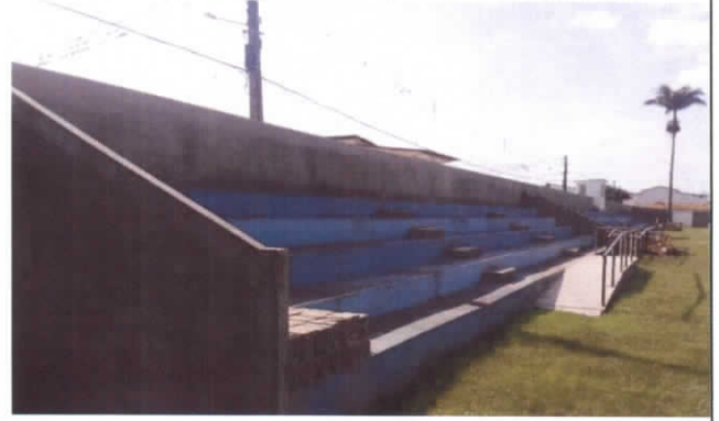
Foto 06 – Execução da rampa de acessibilidade
