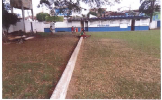
Foto 02 – Remoção do Alambrado P/Execução do Muro
