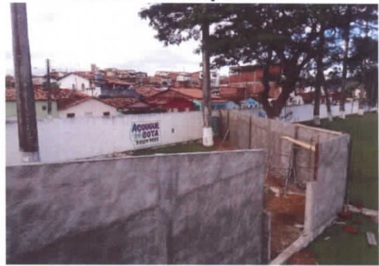
Foto 12 – Construção do Muro
