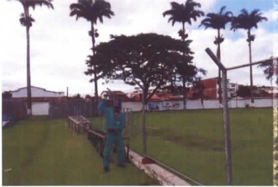
Foto 01 – Remoção do Alambrado P/Substituição
