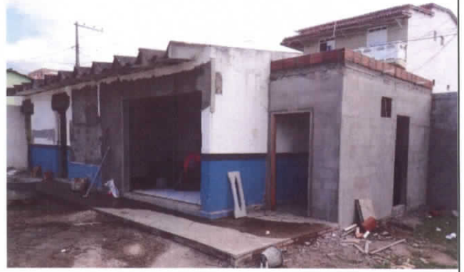
Foto 08 – Execução do banheiro PNE
