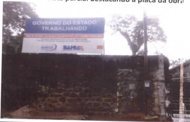
Foto 05 – Vista parcial destacando a placa da obra
