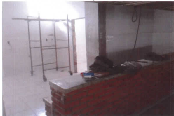
Foto 09 – Construção de bancada
