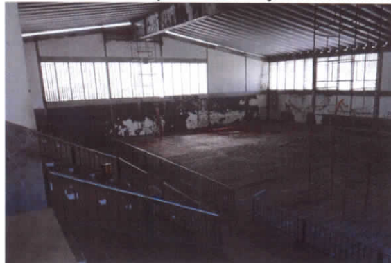
Foto 02 – Andaime para manutenção de cobertura
