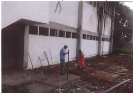
Foto 07 – Remoção de placa de piso
