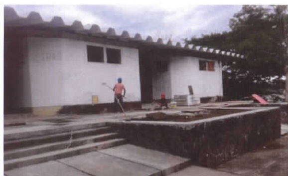
Foto 13 – Pintura nas paredes
