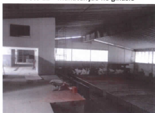
Foto 12 – Manutenção no ginásio
