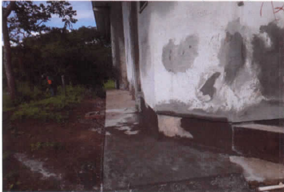
Foto 01 – Manutenção de parede e piso do ginásio
