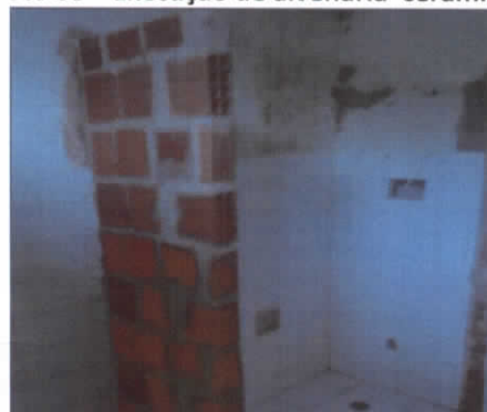
Foto 08 – Execução de alvenaria cerâmica
