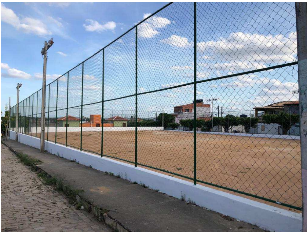
Foto 06 - Reforma concluída do campo do Paulista e vestiário
