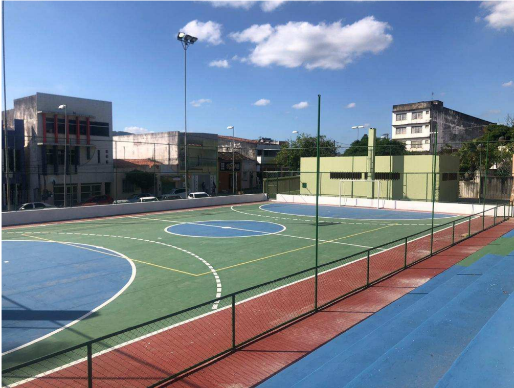
Foto 05 - Quadra e vestiário reformados da praça Luiz Viana - Campo do Gado
