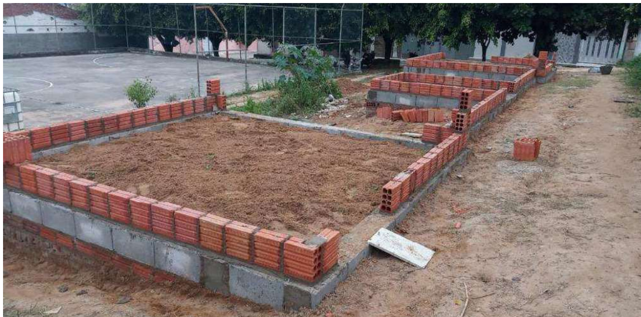
Foto 02 - Aterro para nivelamento do campo.
