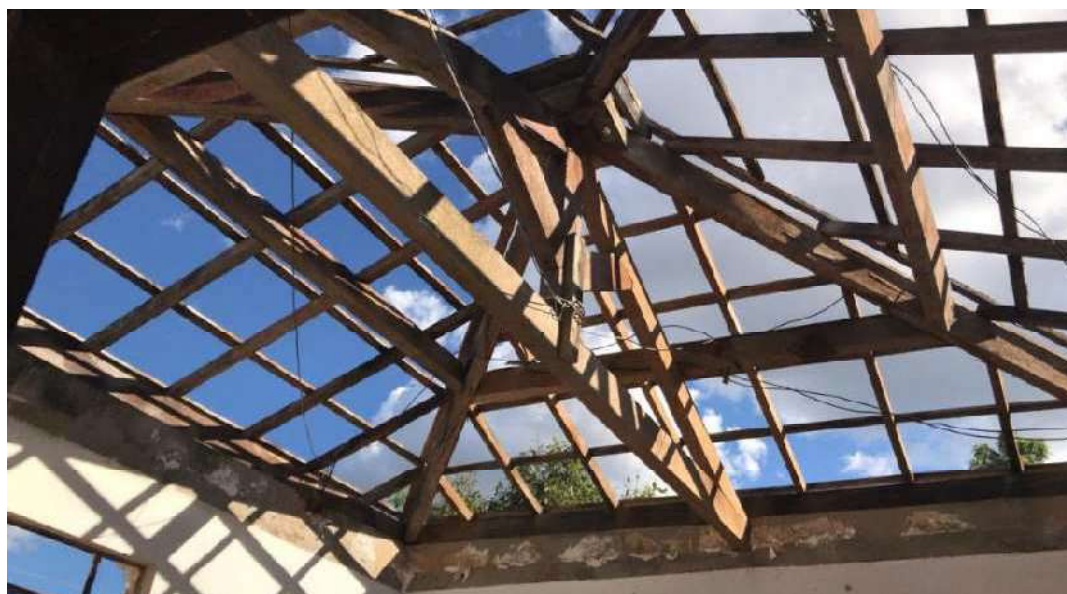
Foto 03 - Reforma do telhado
