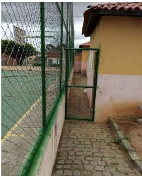
Foto 01 - Reforma do alambrado
