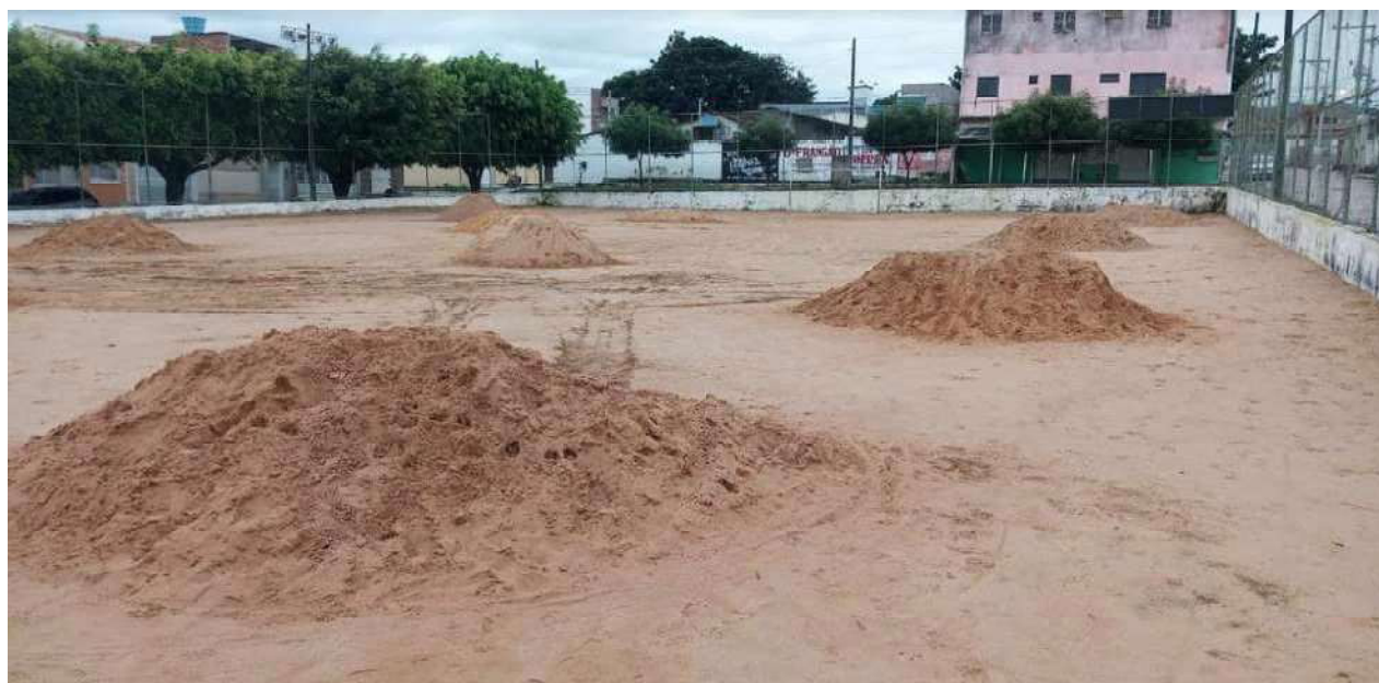
Foto 02 - Aterro para nivelamento do campo.
