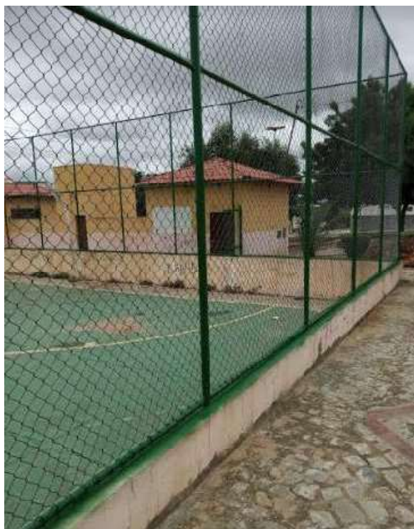
Foto 02 - Reforma do alambrado
