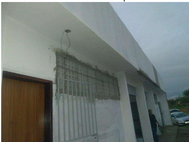
Foto 03 - Vista externa do sanitário público e bar
