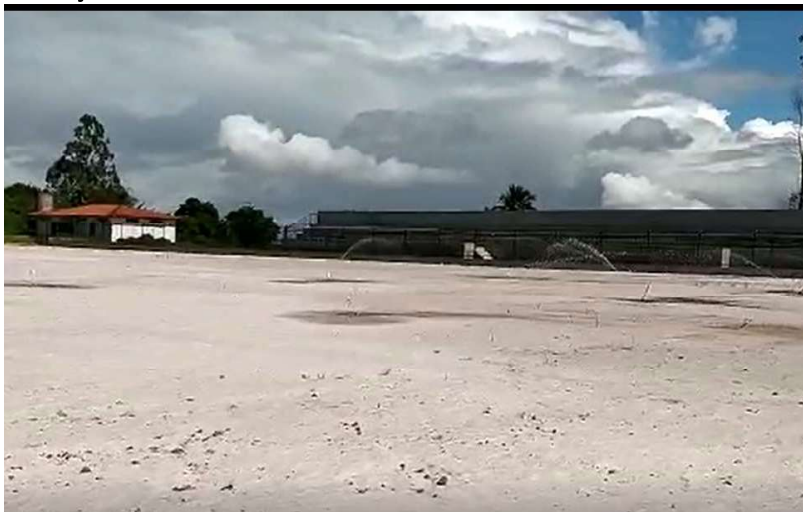
Foto 06- Vista parcial destacando o alambrado, o sistema de irrigação e o gramado em execução
