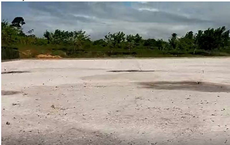
Foto 05- Vista parcial destacando o alambrado, o sistema de irrigação e o gramado em execução
