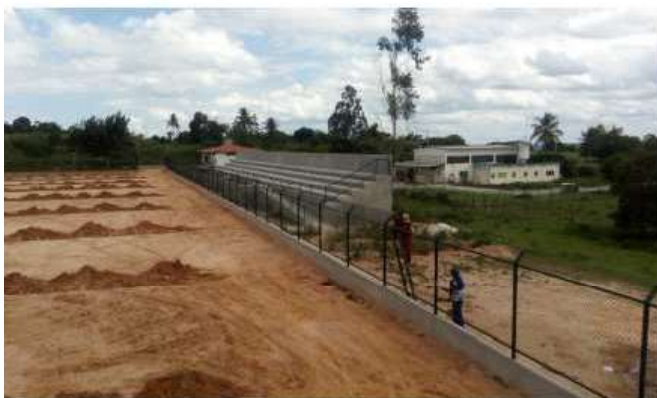
Foto 03 – Vista parcial destacando o alambrado e a arquibancada construídos
