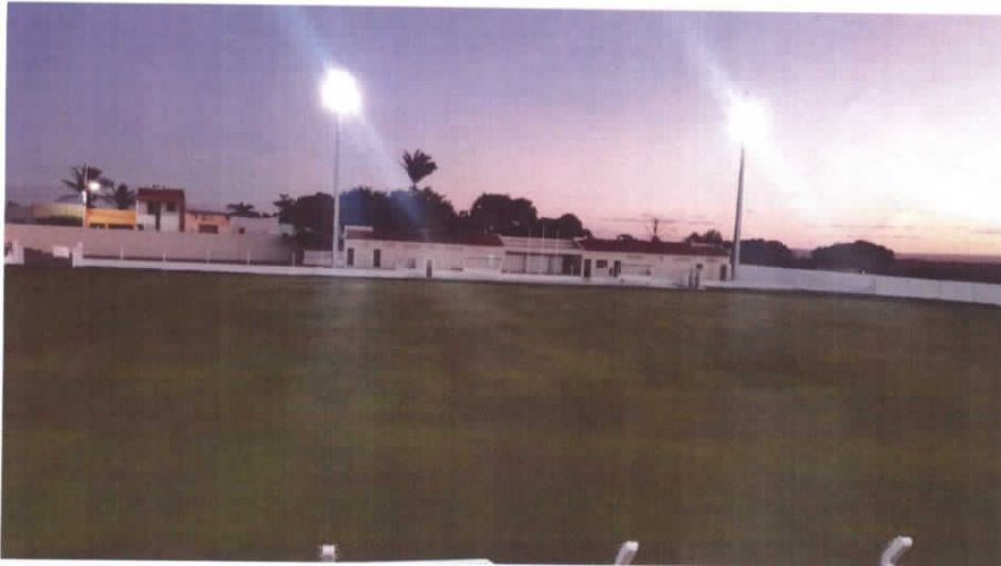
Foto 02 – Vista Geral destacando teste dos refletores
