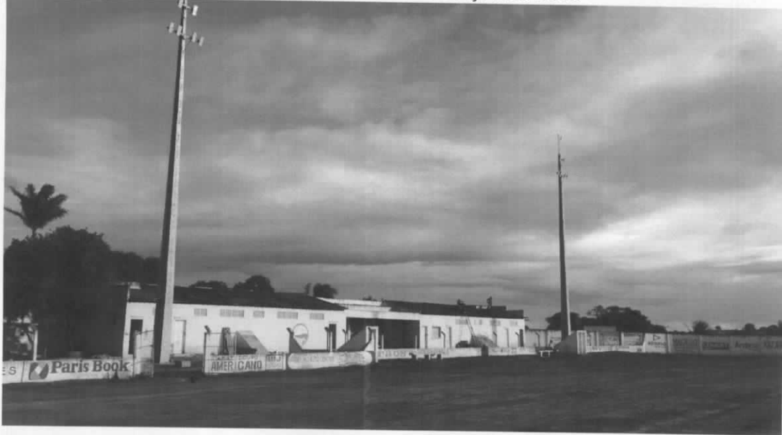
Foto 03 - Vista parcial destacando os postes e refletores já instalados.
