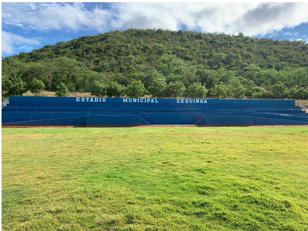
FOTO 02 – VISTA ESTACANDO A ARQUIBANCADA
