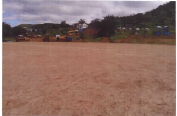
Foto 02 – Vista Geral destacando ausência da grama
