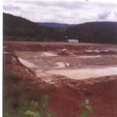
Foto 04 – execução do gramado
