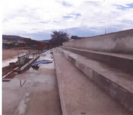
Foto 02 – Superestrutura da Arquibancada
