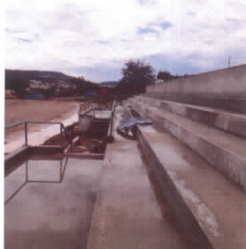
Foto 03 – Superestrutura da Arquibancada
