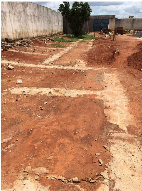
**Foto 02 - Fundação da arquibancada em alvenaria de pedra argamassada .**
