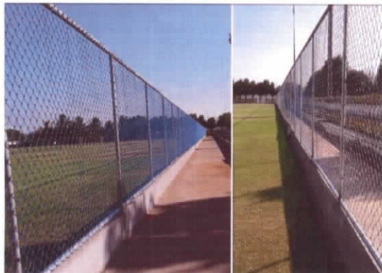
Foto 03 – Visão Geral do Gradil
