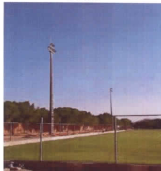
Foto 04 – Visão Poste, Gradil, Mureta, Refletores e SPDA
