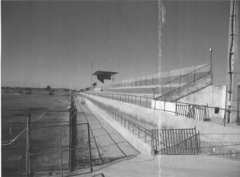
Foto 03 – Vista parcial destacando a arquibancada e alambrado.
