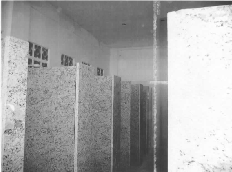
Foto 04 – Vista parcial interna do vestiário.
