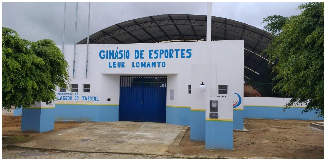
Foto 01 - Fachada da Quadra Coberta
