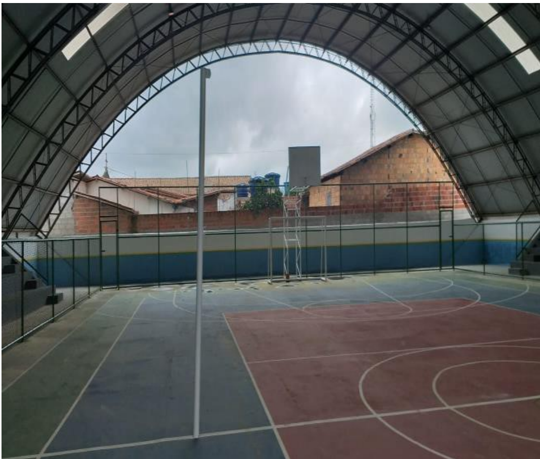
Foto 07 - Instalação dos Equipamentos esportivos
