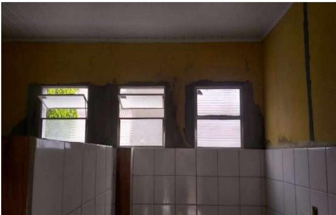
Foto 02 - Colocação das janelas em alumínio nos vestiários
