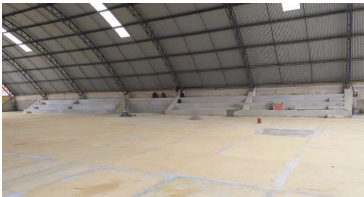
Foto 03 - Reparo do piso e arquibancadas
