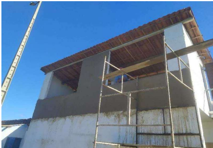
Foto 03 – Execução da edificação interna no setor da arquibancada.
