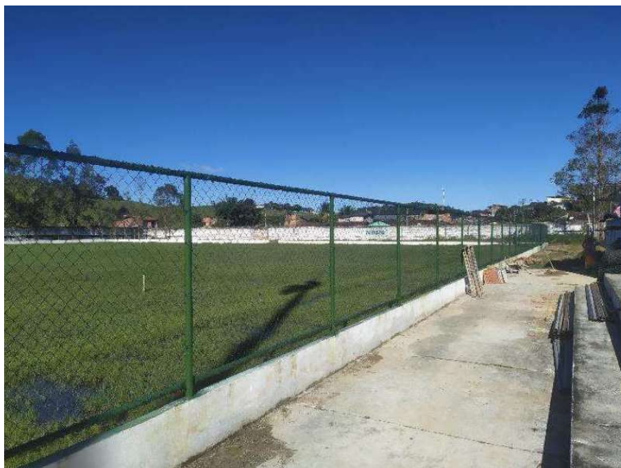
Foto 04 – Vista do alambrado
