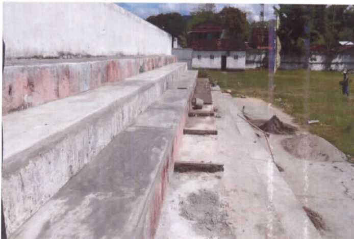
Foto 02 – Reforma da arquibancada.
