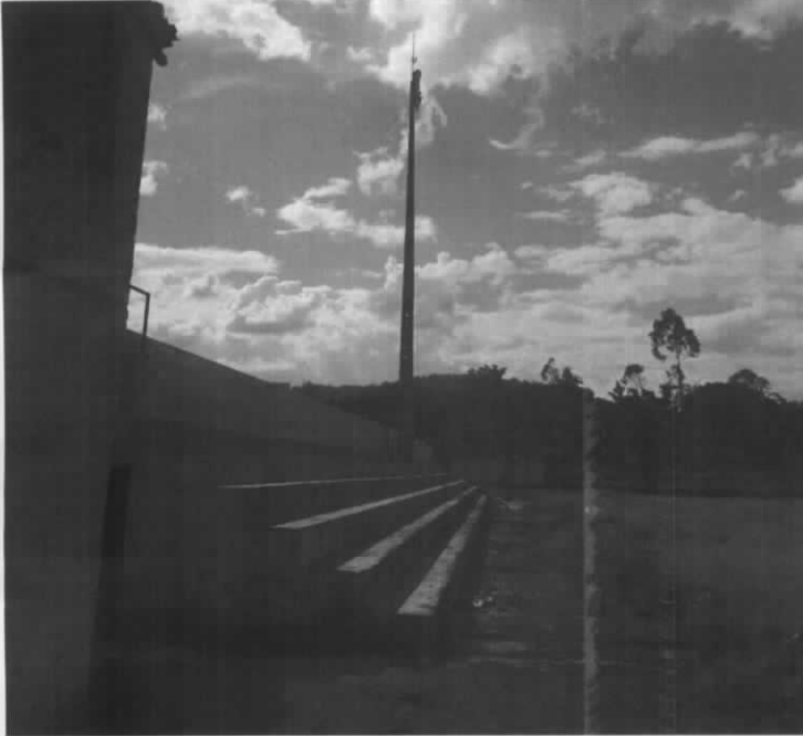
Foto 03 – Vista dos postes e refletores instalados
