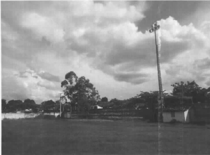
Foto 02 – Vista dos postes e refletores instalados
