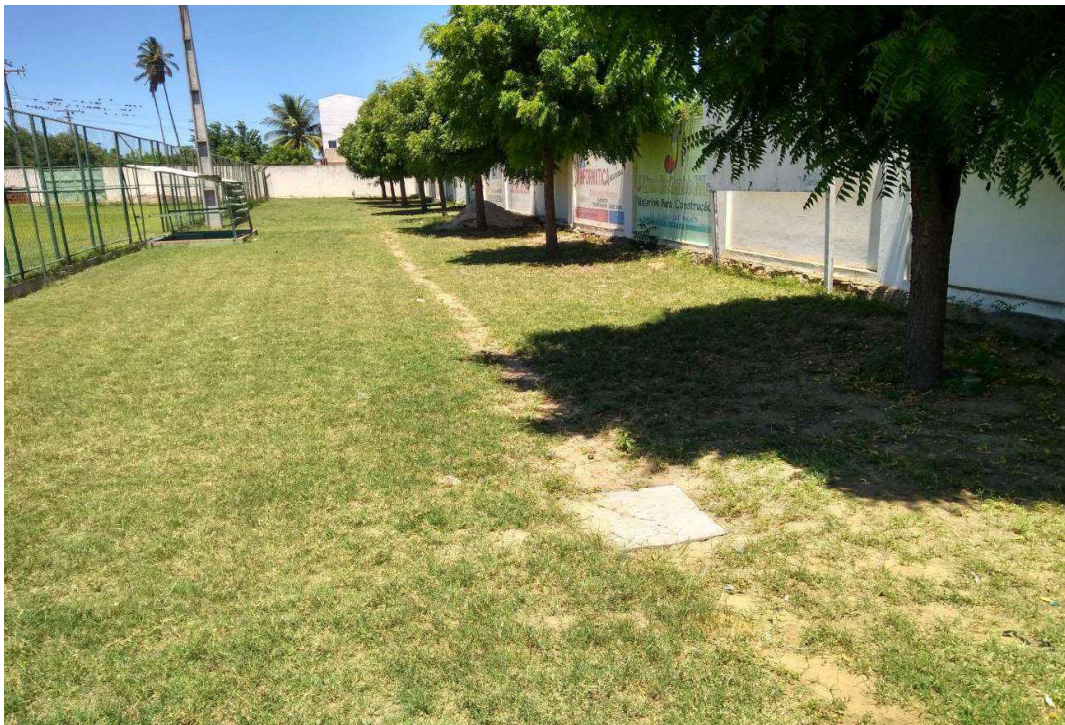
Foto 01 – Caixas de passagem.
