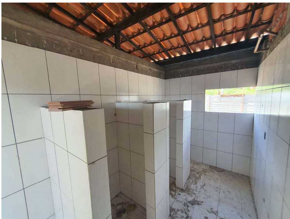
Foto 04 - Execução do revestimento cerâmico.
