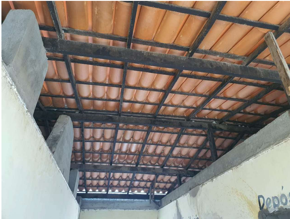
Foto 03 - Execução da cobertura.
