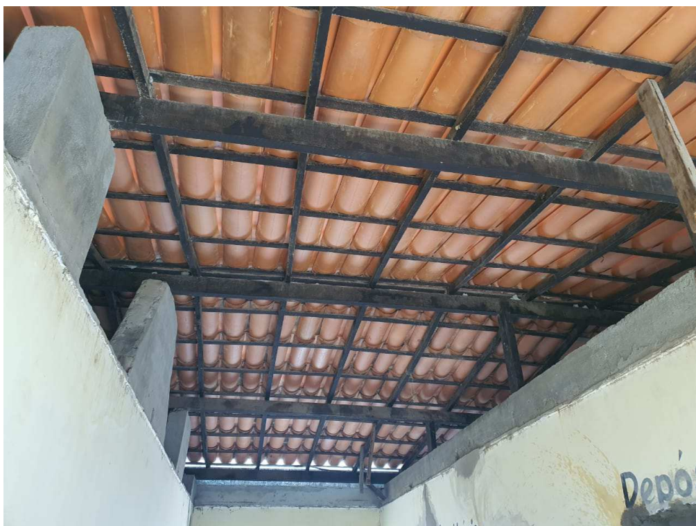
Foto 03 - Execução da cobertura.
