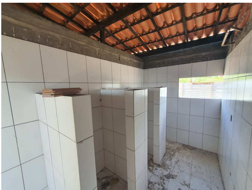
Foto 04 - Execução do revestimento cerâmico.
