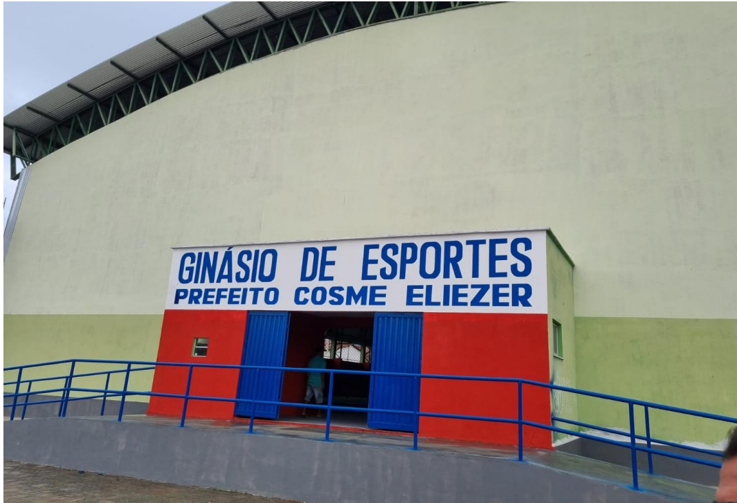
Foto 01 – complementação de construção de quadra coberta
