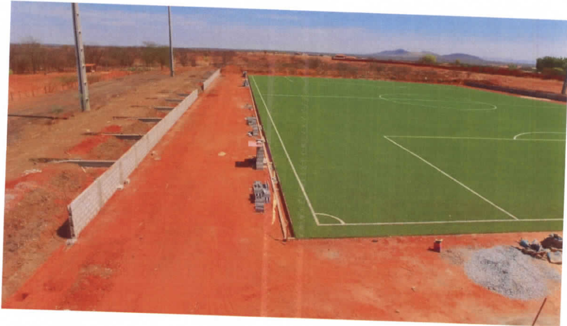
FOTO 02 – Vista parcial a grama sintética instalada.
