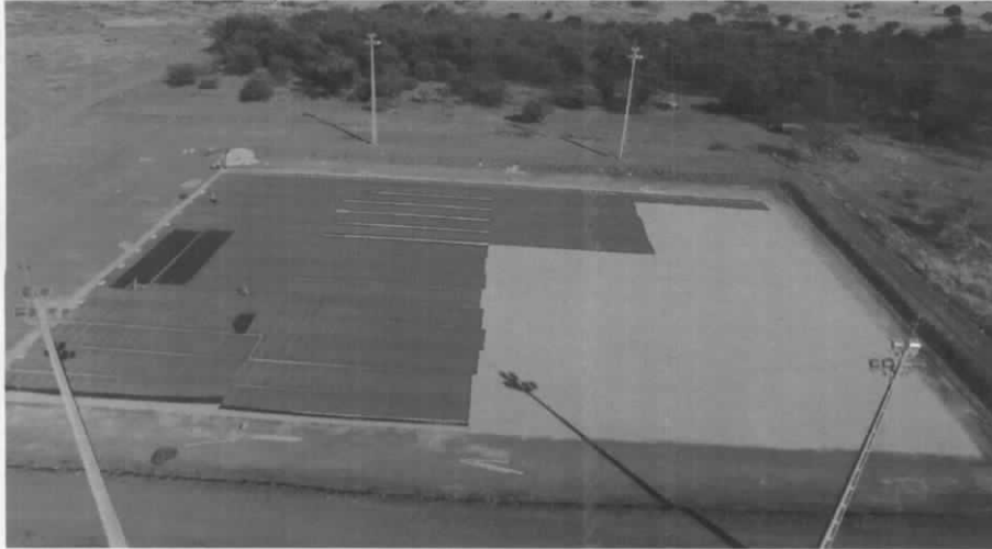
FOTO 01 – Vista geral destacando postes de iluminação instalado e instalação da grama sintética em execução.
