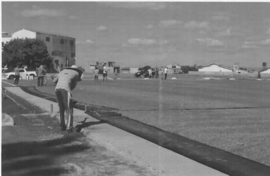
FOTO 02 – Vista parcial destacando a instalação da grama sintética
