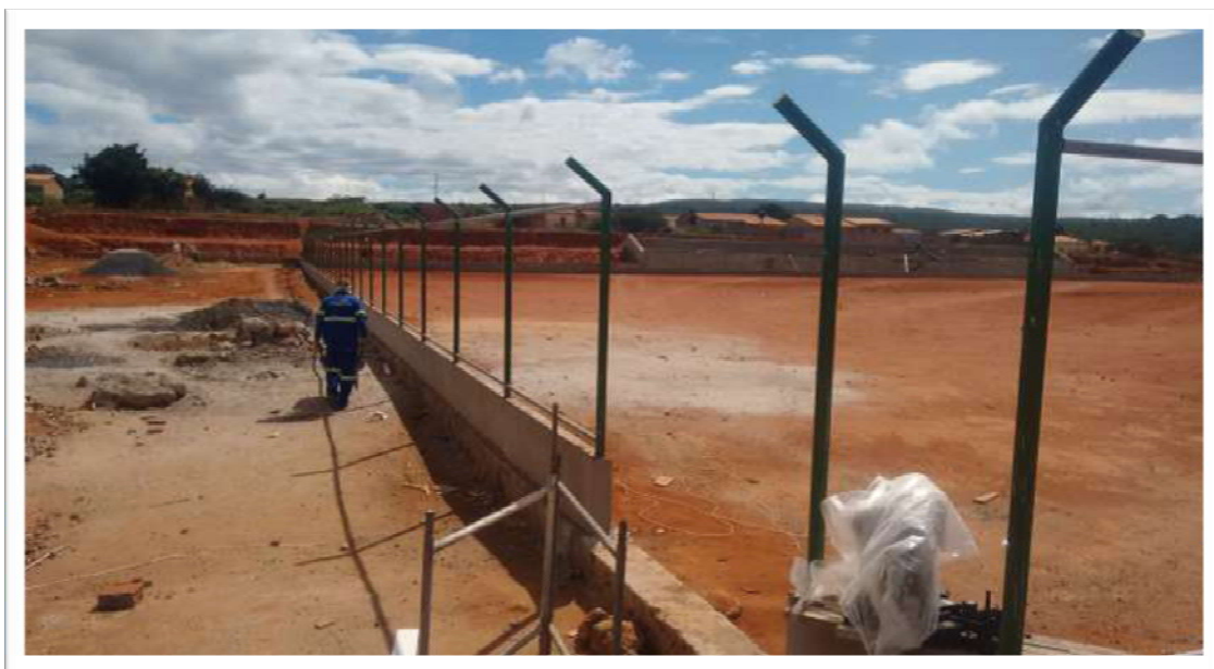
Foto 03 - Vista mureta e perfis do alambrado
