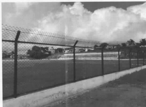
Foto 03 – Foto Geral destacando o alambrado
