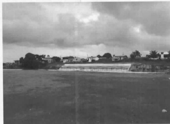
Foto 02 – Foto Geral destacando a arquibancada
