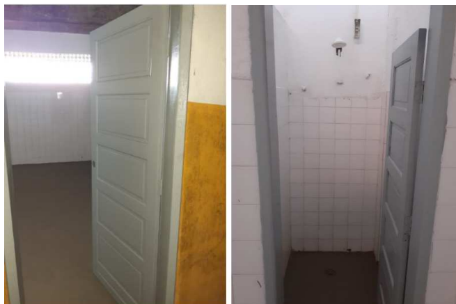
Foto 08 e 09 – Reforma dos sanitários e vestiários
