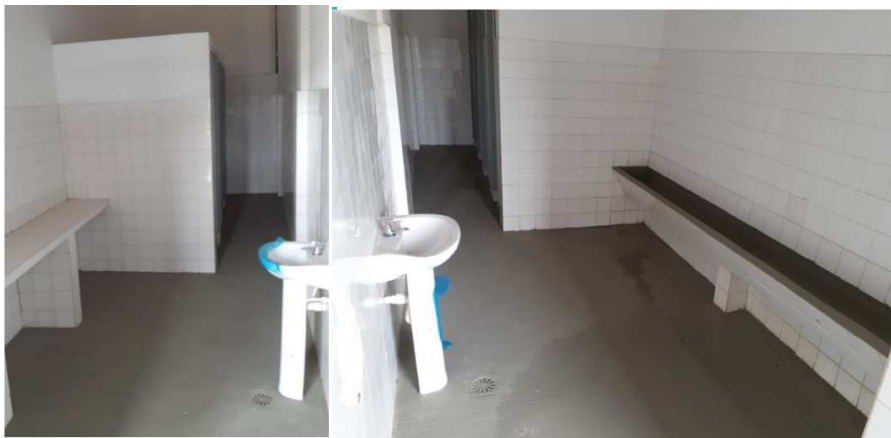
Foto 06 e 07 – Reforma dos sanitários e vestiários
