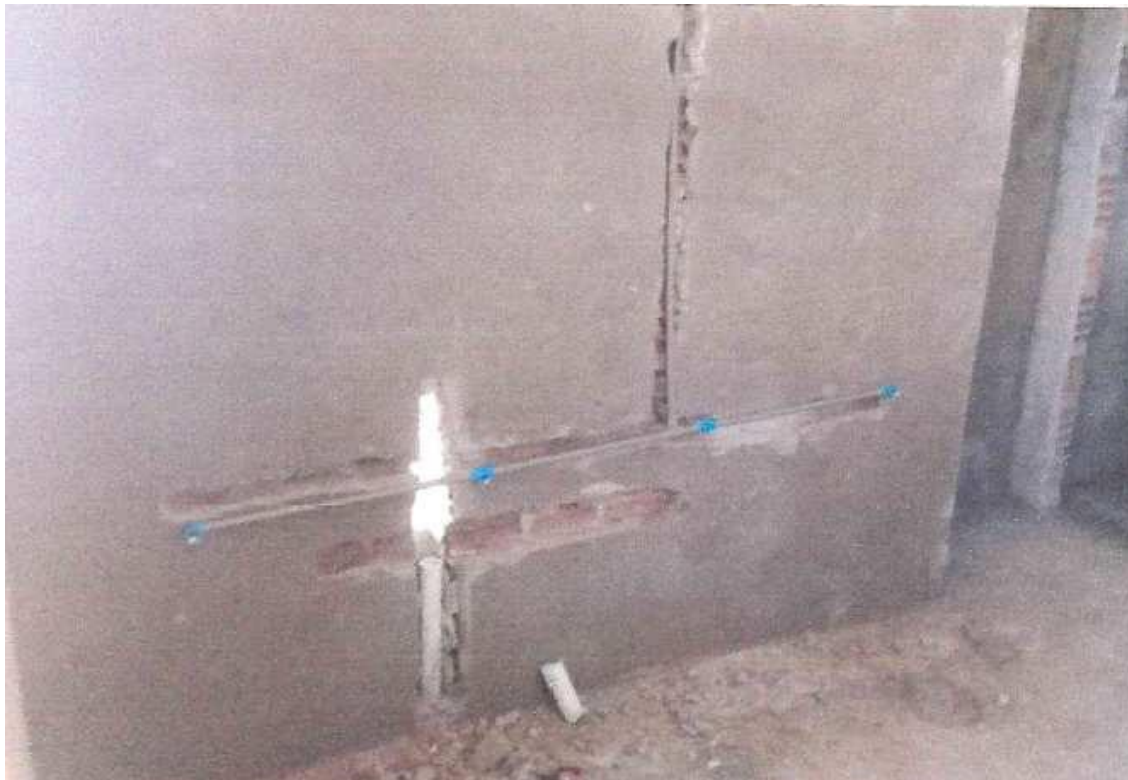
Foto 03 Construção do vestiário, iniciando as instalações hidráulicas.
