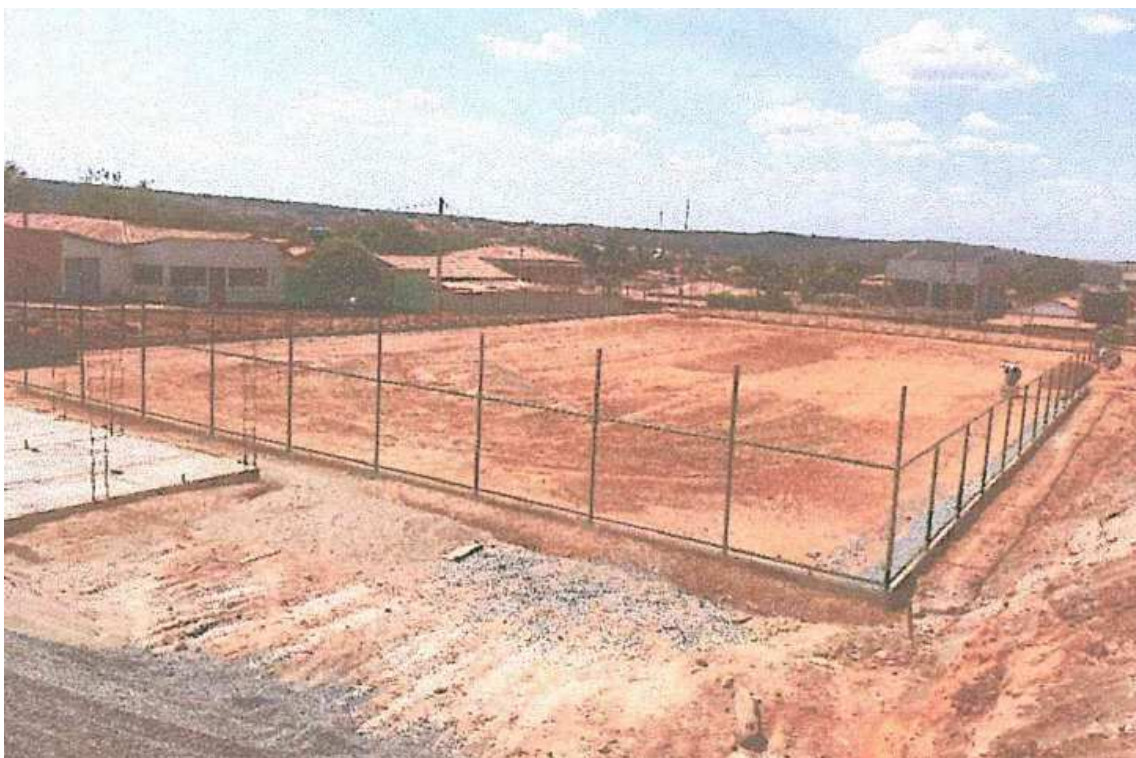
Foto 04 - Mureta e perfis do alambrado
