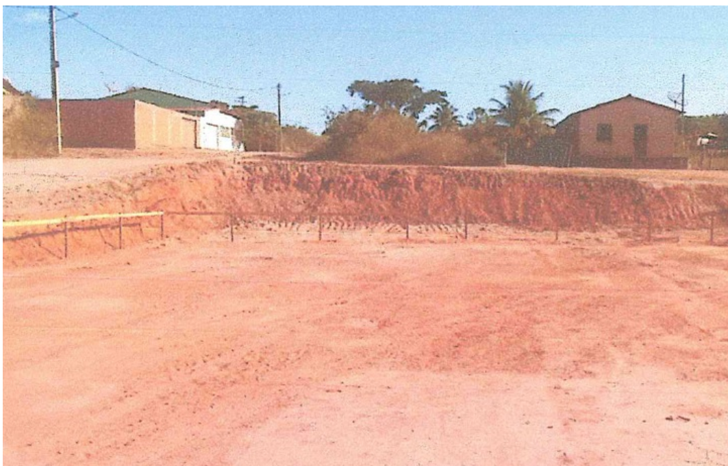
Foto 02 - Gabarito e nivelamento do campo
