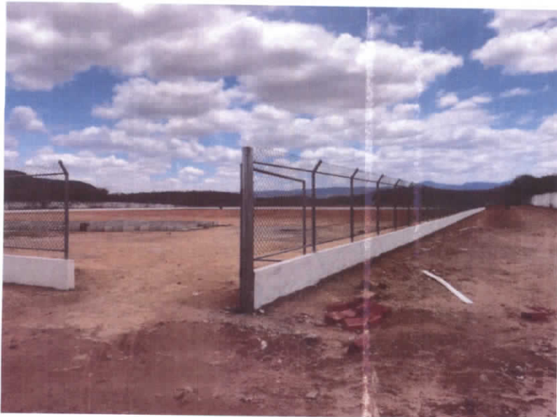
FOTO 02 – Vista Geral destacando o alambrado
