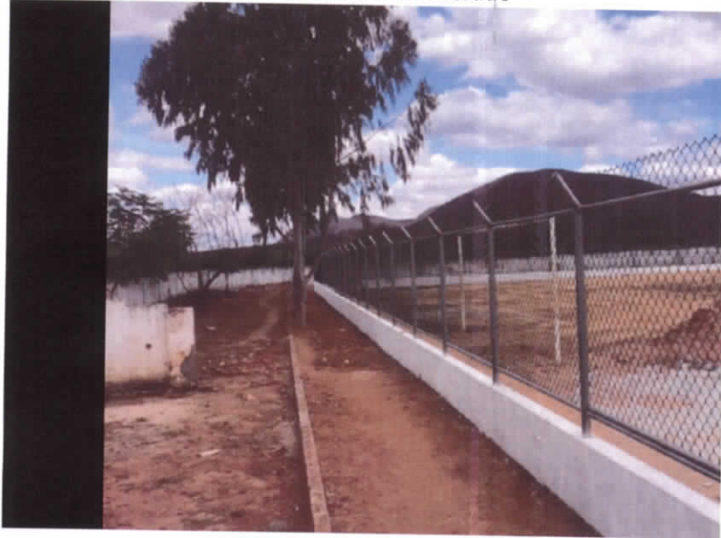
FOTO 01 – Vista Geral destacando o alambrado
