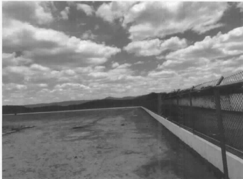
FOTO 01 – Vista Geral destacando o alambrado
