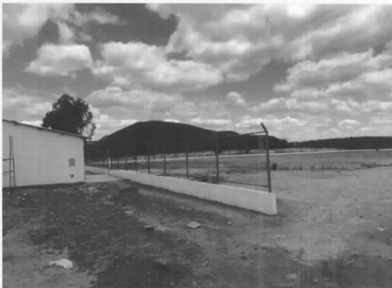
FOTO 02 – Vista Geral destacando o alambrado o vestiário
