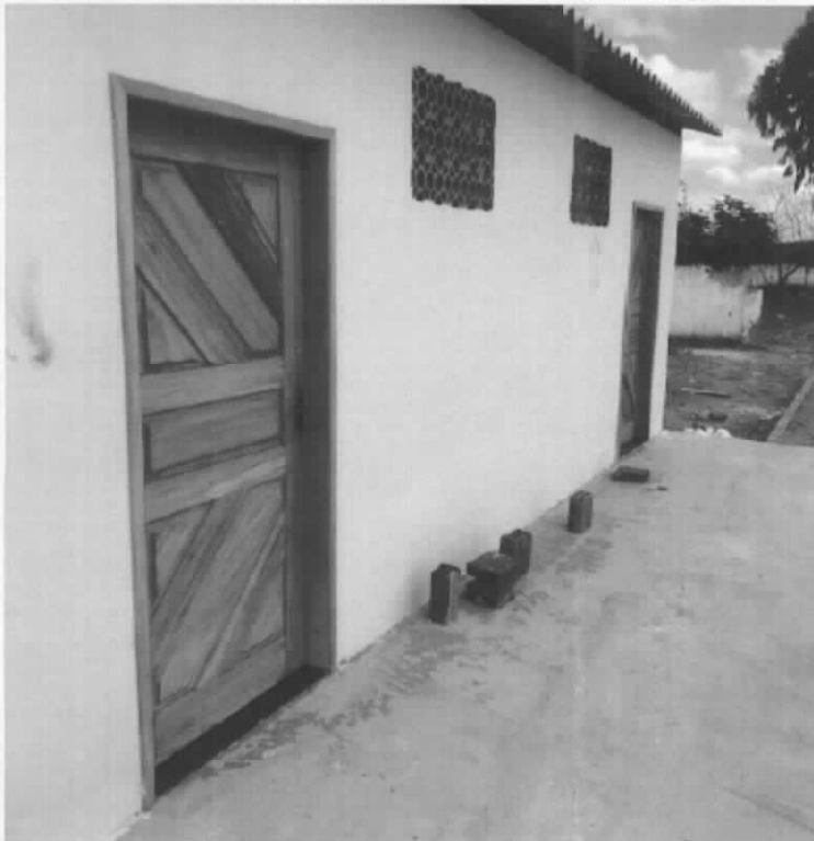
FOTO 03 – Vista Geral destacando o alambrado e o vestiário
