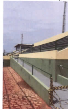
Foto 02 – Degraus da Arquibancada
