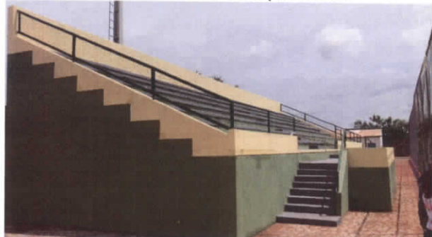
Foto 01 – Escada da Arquibancada
