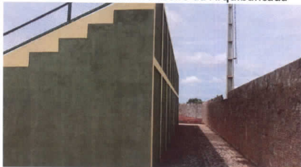
Foto 04 – Fechamento traseiro da Arquibancada
