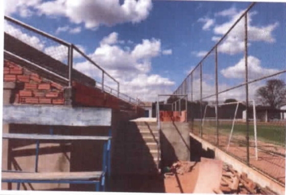
Foto 01 – Escada da Arquibancada
