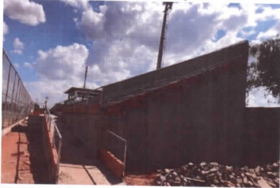
Foto 03 – Rampa da Arquibancada
