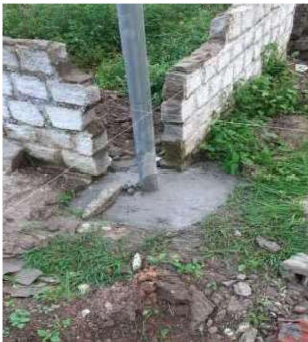
Foto 04 - Marcação de gabarito para levantamento de alvenaria
