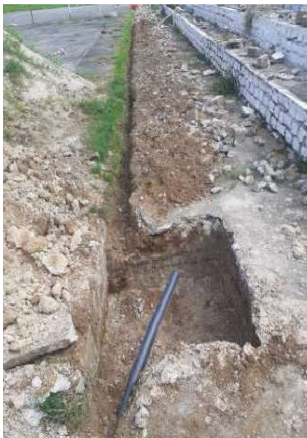
Foto 02 - Escavação manual para caixa de passagem
