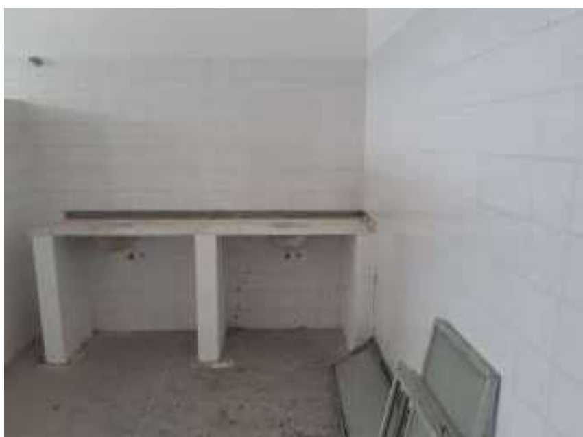
Foto 04 - Restauração dos sanitários
