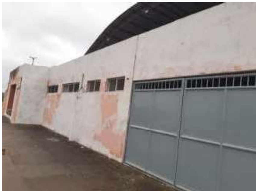
Foto 03 - Fachada do Ginásio recebendo pintura
