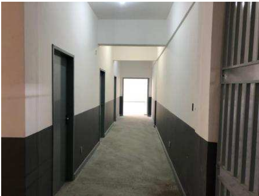
Foto 03 - Área interna pintada e com as esquadrias
