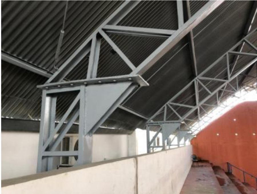
Foto 01 - Reforma do estrutura metálica da cobertura
