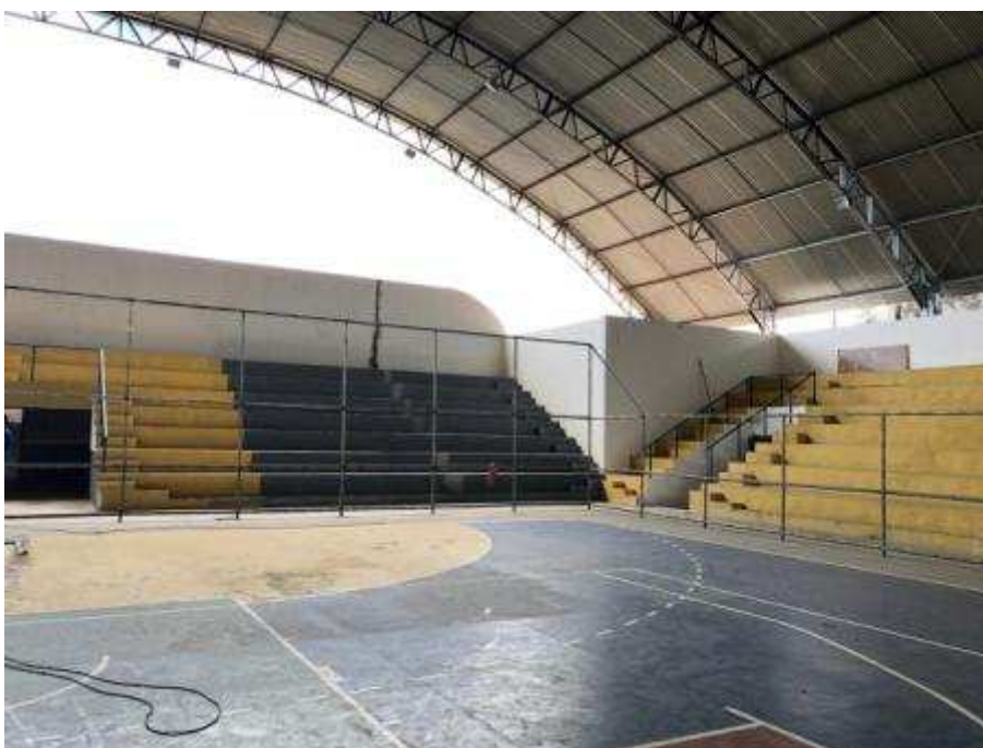
Foto 04 - Alambrado interno em construção
