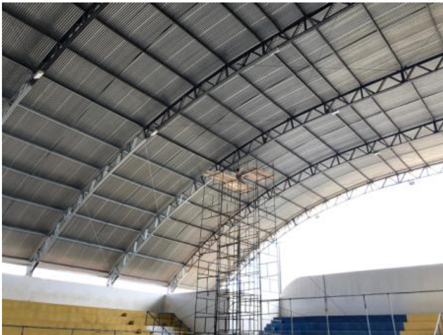
Foto 02 - Telhamento com telha de metálica
