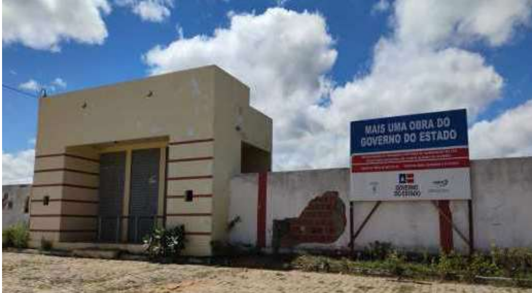
Foto 01 - Vista da Placa da Obra
