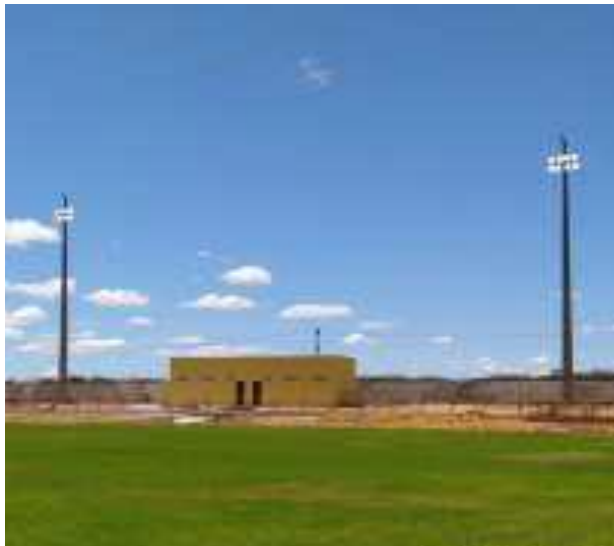
Foto 01 – Vistas dos postes de iluminação.
