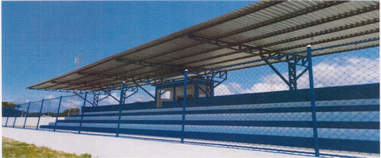
Foto 01 –Alambrado, Arquibancada e pintura.
