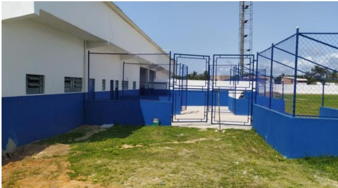
Foto 01 – Substituição do alambrado e pintura.
