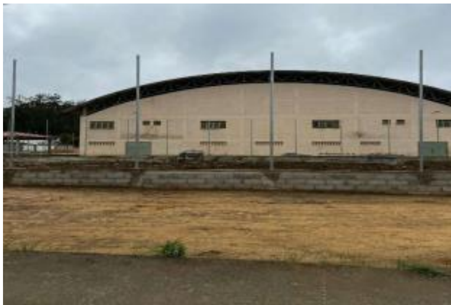
Foto 02 – Execução de areninha.
