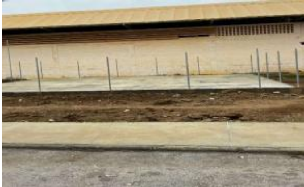
Foto 03 – Execução de parque infantil.
