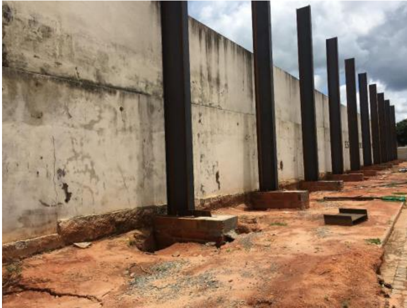
Foto 02 - Execução de cobertura metálica em arquibancada existente.
