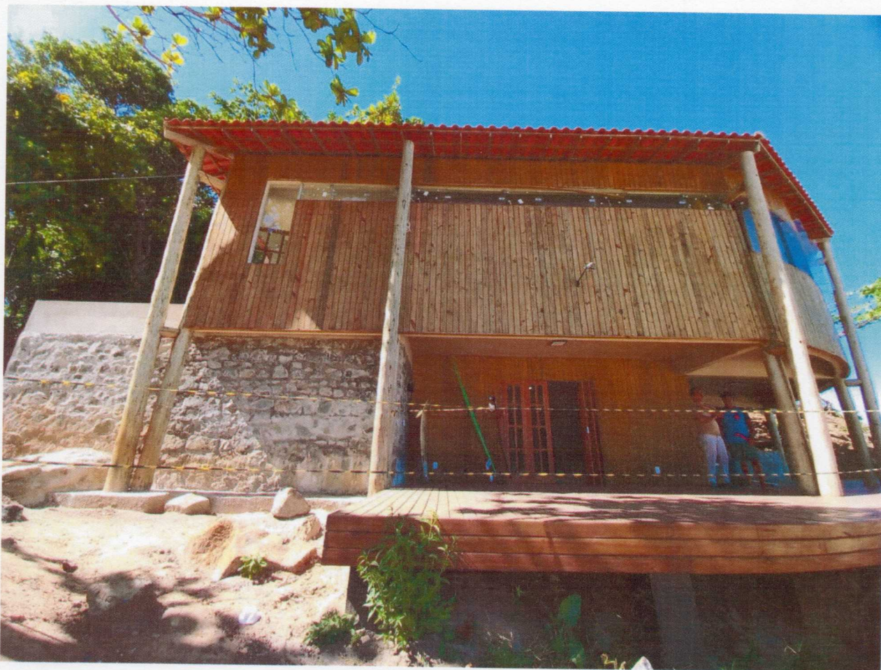
Foto 01 – Vista do revestimento externo.
