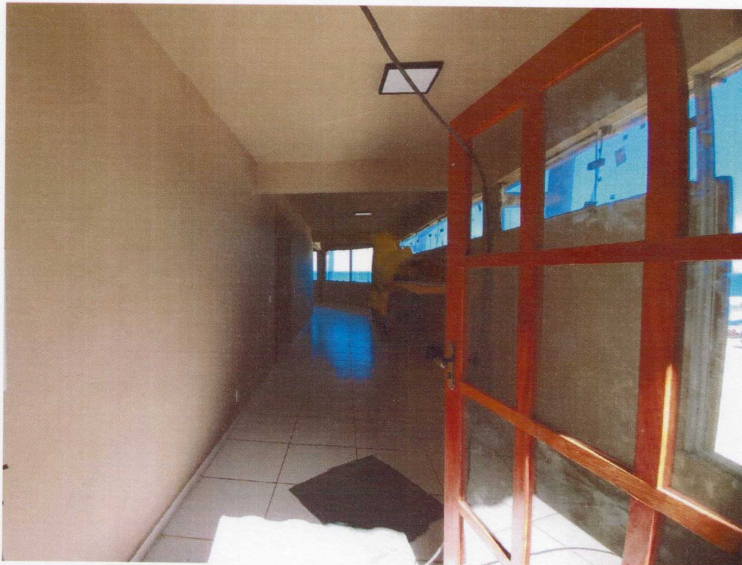
Foto 02 – Conclusão da pintura e acabamentos internos no pavimento superior.
