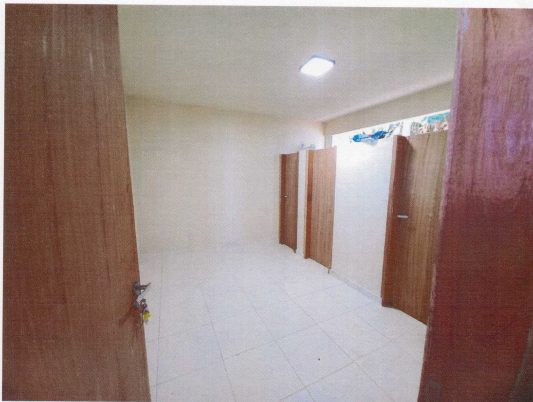
Foto 03 – Conclusão dos acabamentos nos sanitários.
