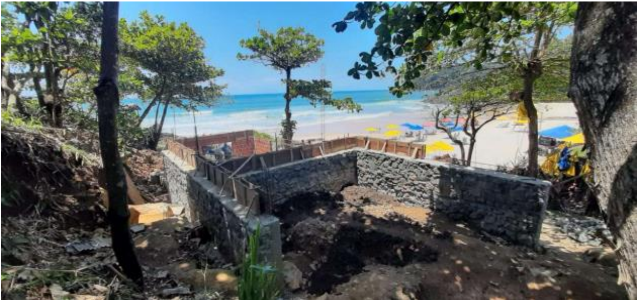
Foto 01 – Execução de alvenaria em pedra.
